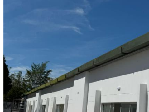
CANAL METALICO- VIGA CANAL
