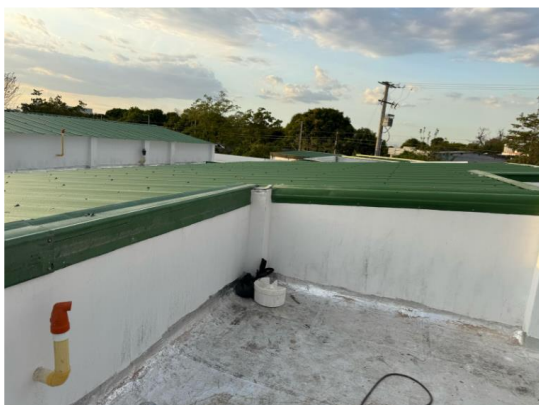
INSTALACION DE REMATE FINAL DE MURO
