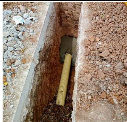
CONEXIÓN TUBERIAS-AGUAS RESIDUALES
